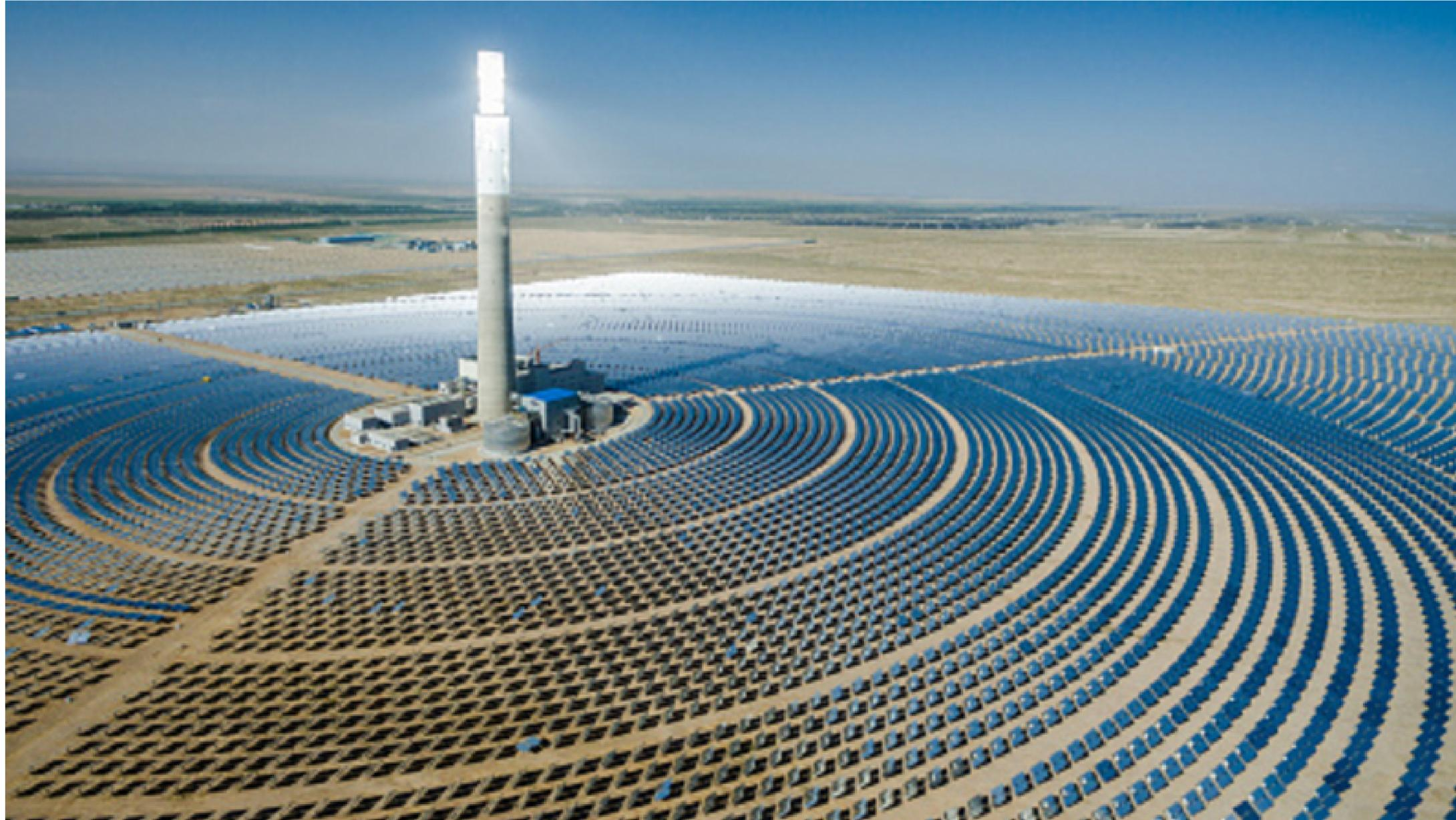
Il **solare** termodinamico, che sfrutta l'**energia solare** utilizza come principio di base quello delle centrali **termiche** classiche, la differenza sta nel metodo in cui viene scaldata l'acqua della caldaia.
