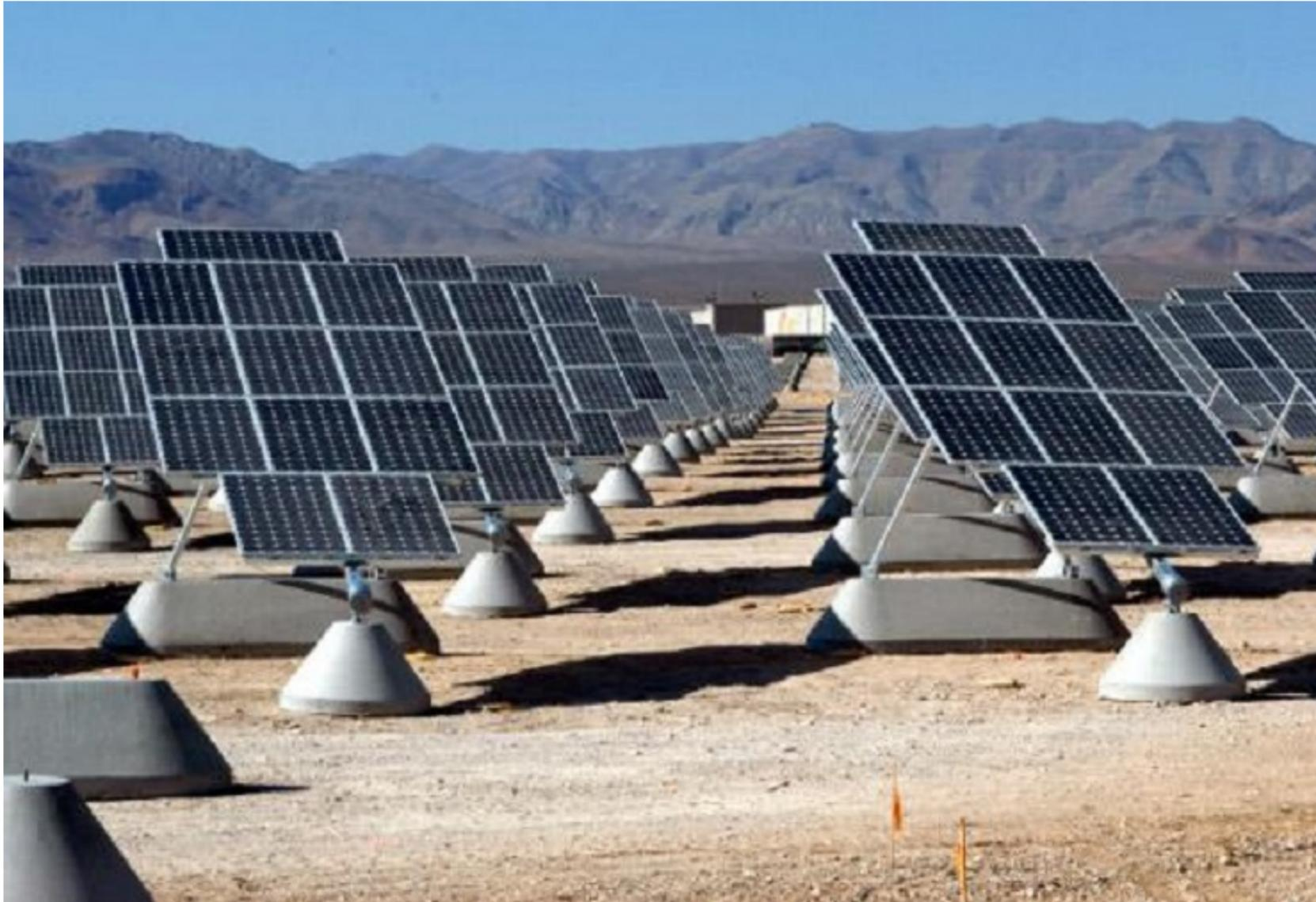
**La centrale solare fotovoltaica è basata sul pannello fotovoltaico e convertono la radiazione solare in corrente elettrica sfruttando l'effetto fotovoltaico.**
